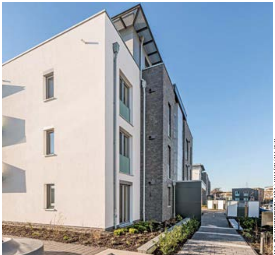
Zum modernen Erscheinungsbild der Gebäude der Kleefeld-Buchholz eG sollen auch die Treppenhäuser passen: Dank sog. digitaler Bretter gehören Zettelwirtschaft und Aushänge der Vergangenheit an
